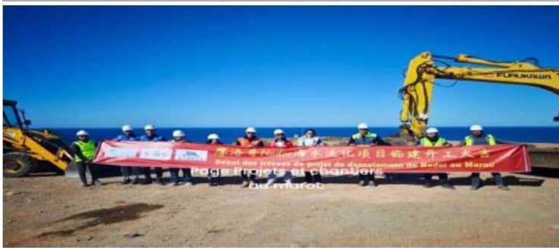
Las obras ya han comenzadoNador City
