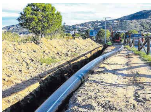
La cañería que trasladará agua hasta El Port de la Selva.
